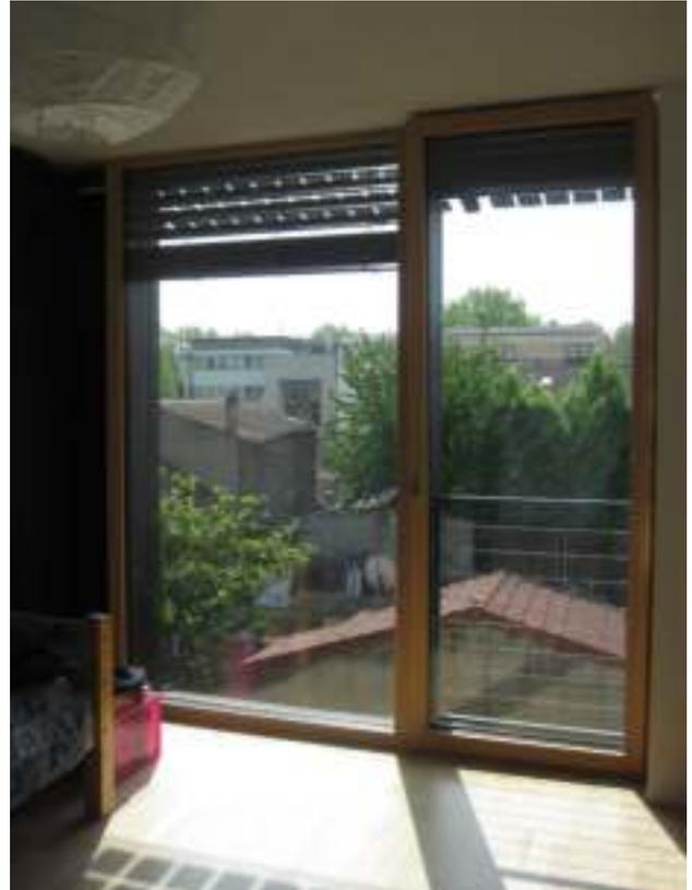
*Les grandes baies vitrées au sud sont équipées de stores à lamelles à l'extérieur, à commande électrique mais manuelle et d'ouvrants opaques de ventilation (à gauche) / Photo URCAUE*
