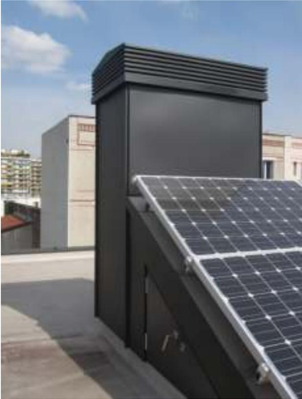
*Vue cheminée d'extraction de la ventilation naturelle et les panneaux solaires en toiture / Photo URCAUE*
