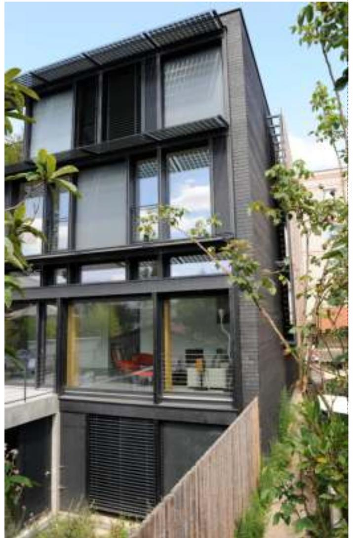
*L'entrée d'air de la ventilation naturelle se fait derrière la grille en bas à gauche
