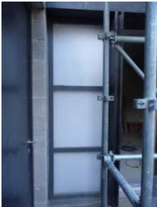
Figure 17 : Entrée du conduit d'air neuf au niveau du jardin (bouchée lors de la visite)
