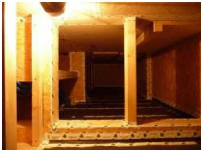
Figure 16 : Conduit d'amenée d'air
