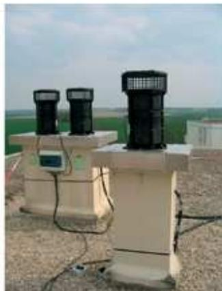
Figure 9 : installation des ventilateurs Helys sur conduits de ventilation naturelle (source : Acthys)
