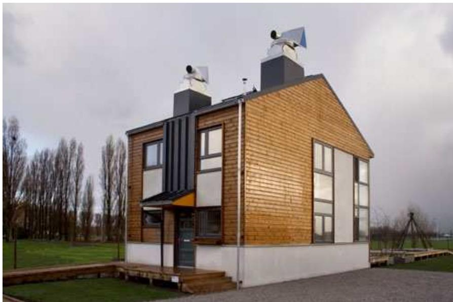
Figure 25 : Maison individuelle Ruralzed à Grande Synthe avec ventilation naturelle double flux (source : Zedfactory)
