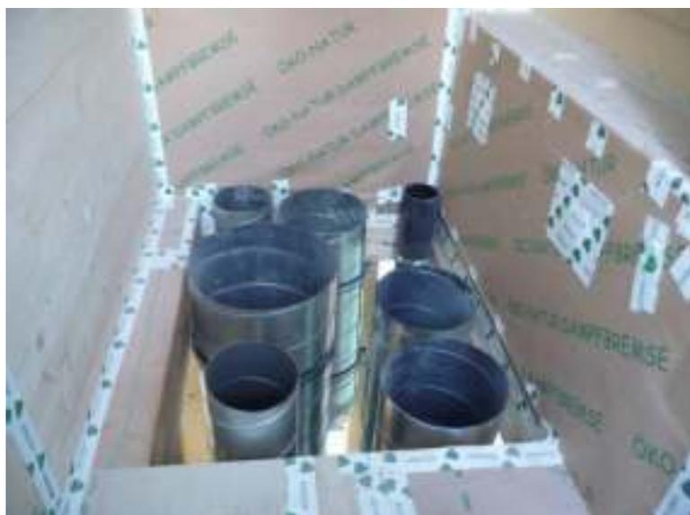
Figure 18 : Haut des conduits d'extraction d'air dans la cheminée
